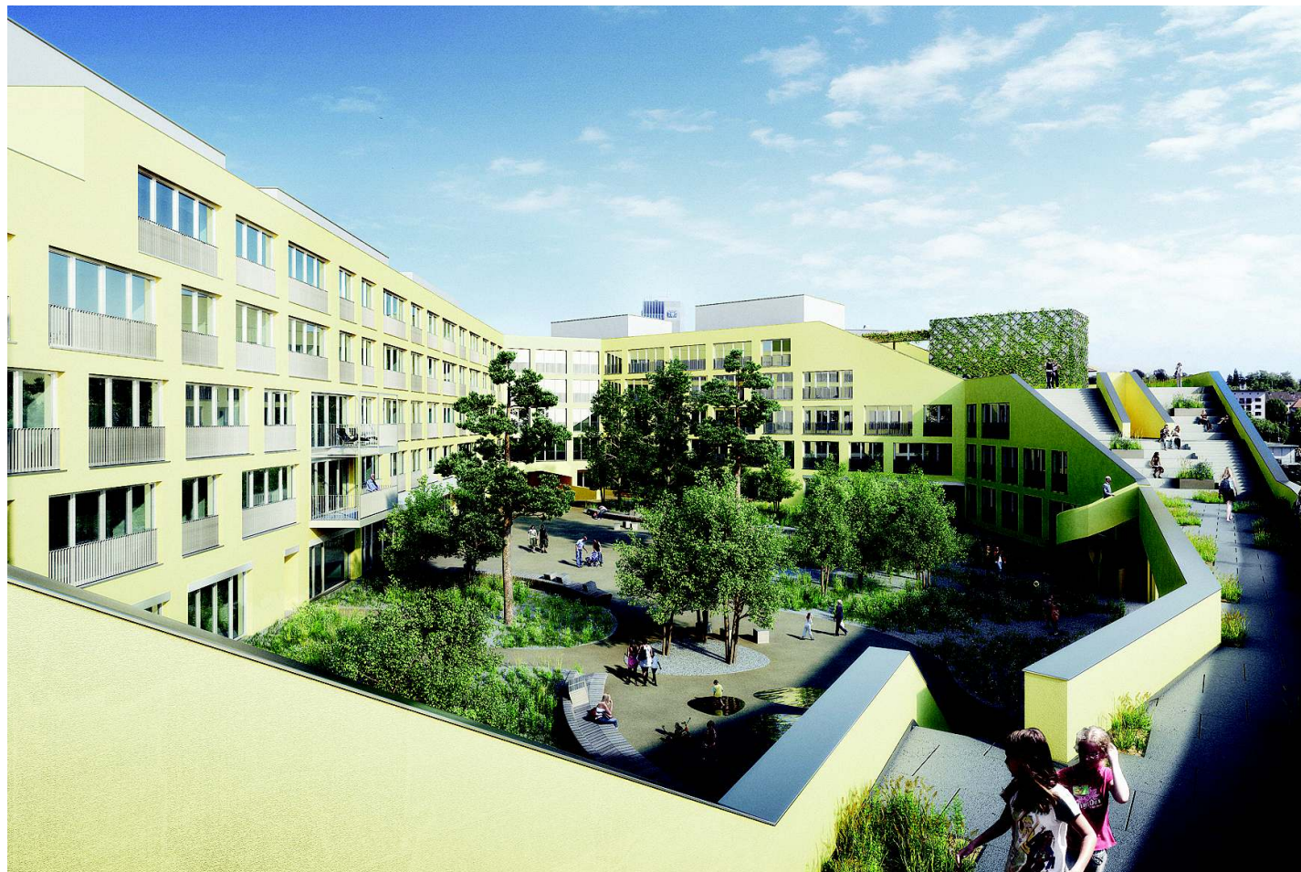
Unter diesem Hof fährt die Straßenbahn: das Projekt Kalkbreite in Zürich Foto: Müller Sigrist
